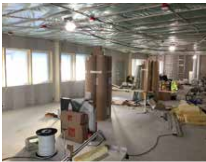
Et lite glimt fra pågående arbeider i den store salen.
